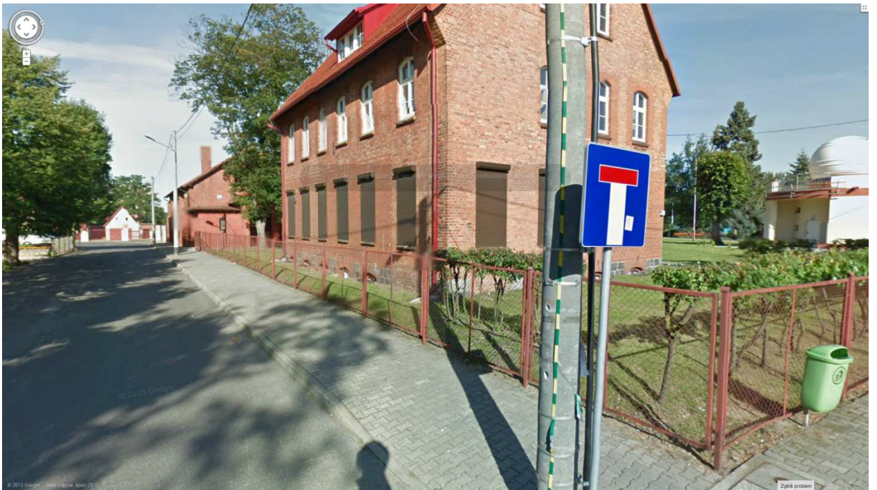
Fot. nr 4. Istniejące ogrodzenie od ul. Sybiraków
