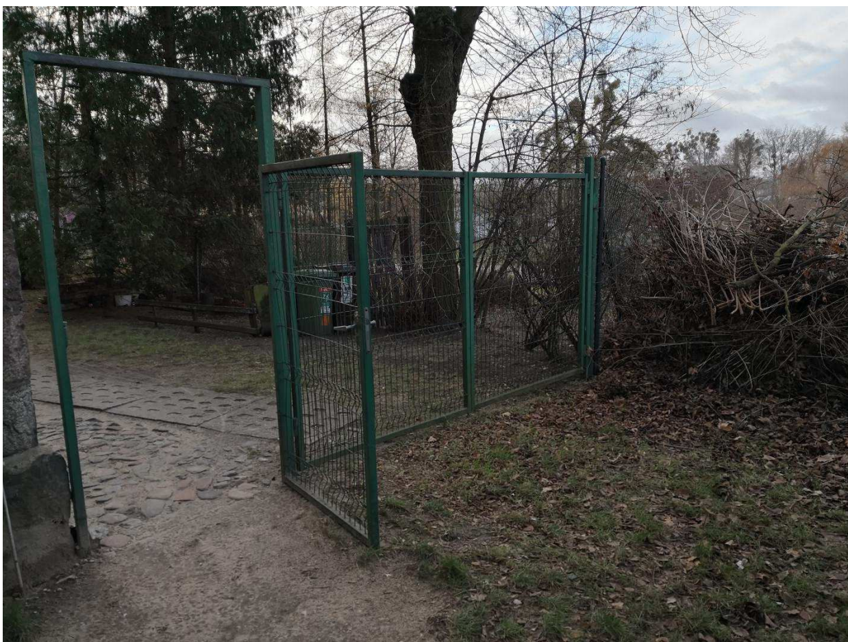
Fot. nr 8. Istniejące ogrodzenie wewnętrzne - brama z furtką
