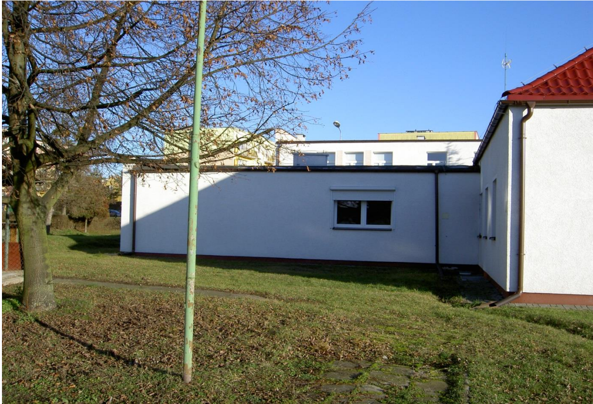
Zdj. 3. ELEWACJA ZACHODNIA
