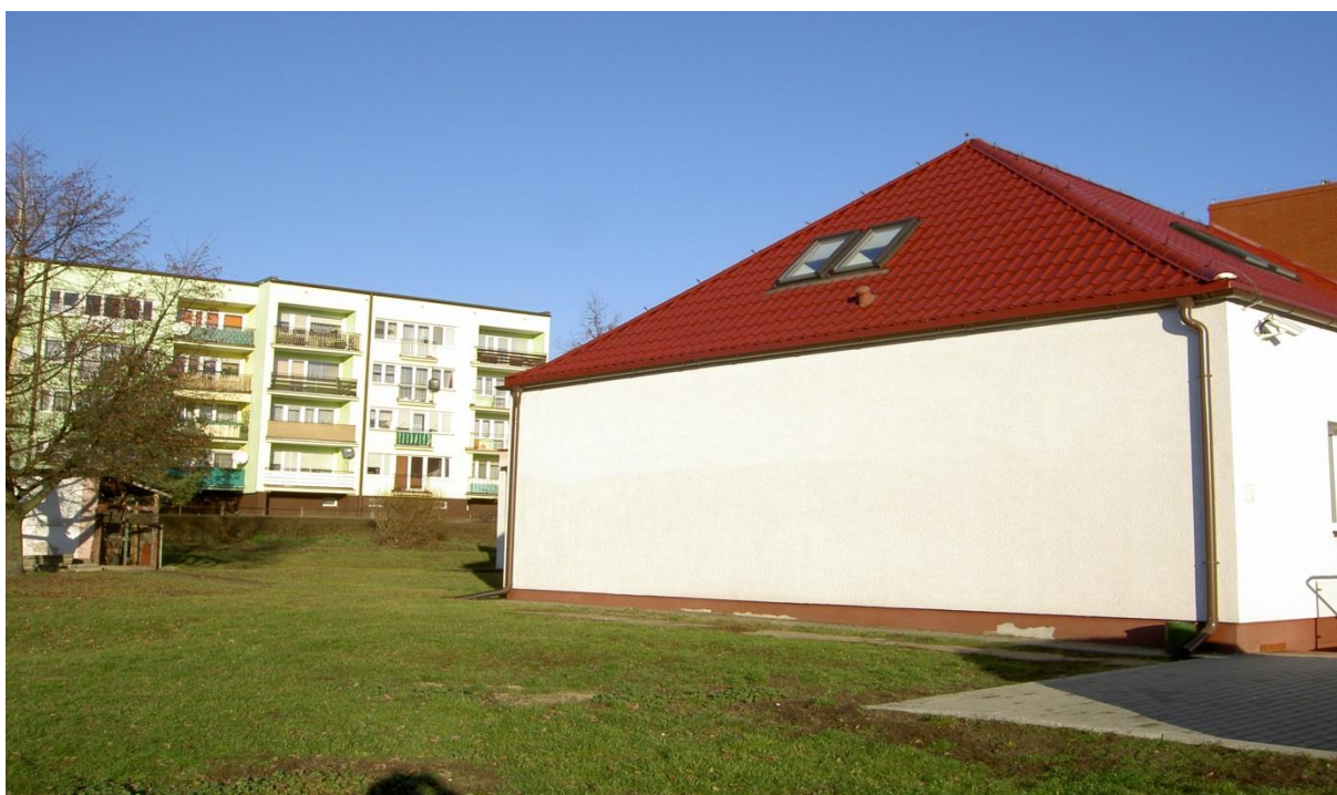
Zdj. 2. ELEWACJA ZACHODNIA
