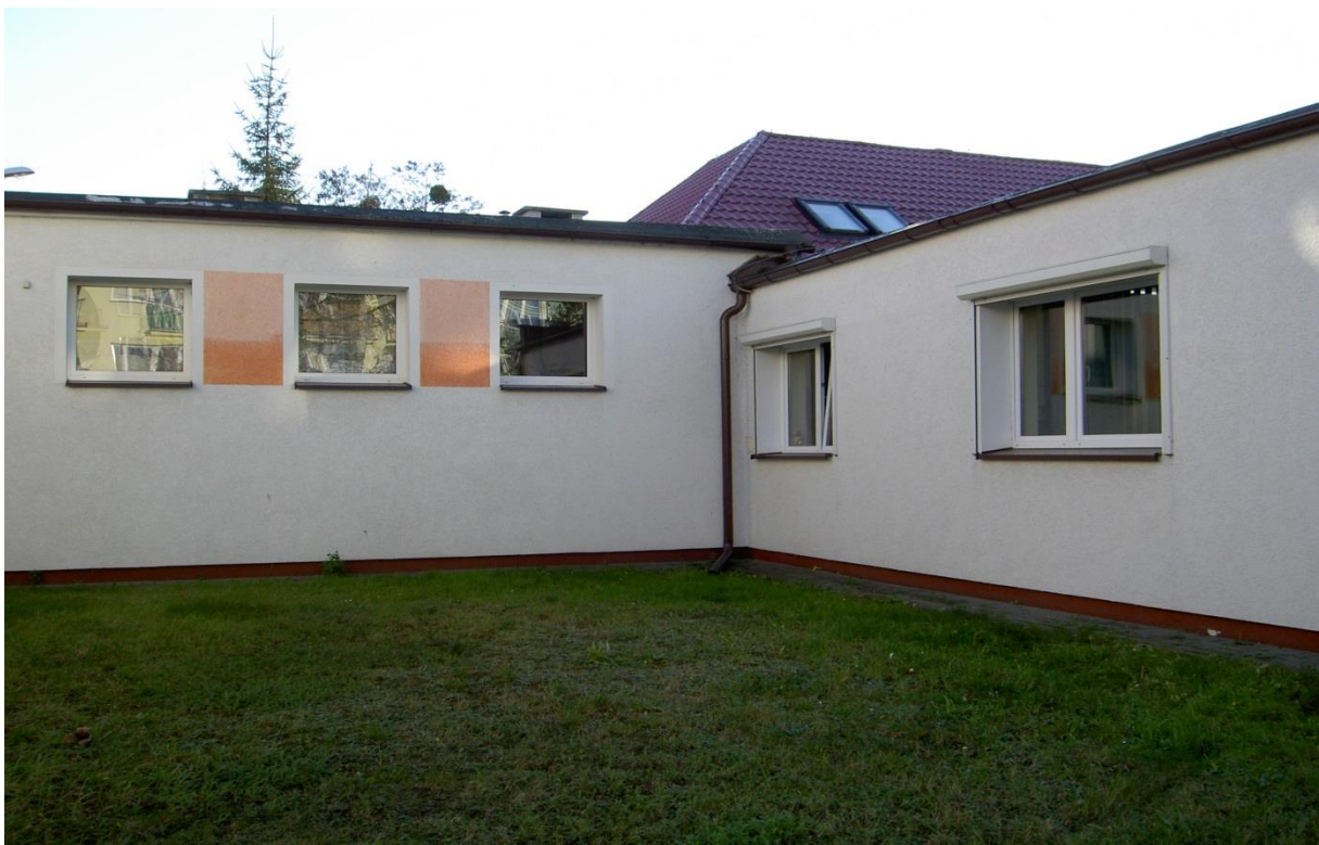
Zdj. 4. ELEWACJA PÓŁNOCNA
