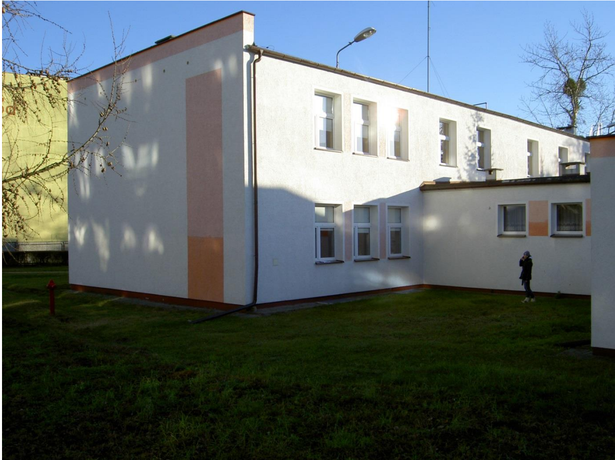
Zdj. 5. ELEWACJA PÓŁNOCNA
