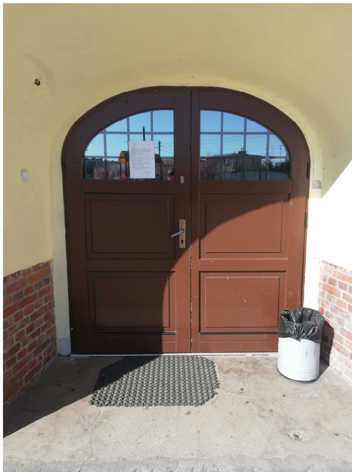
fot. istniejące drzwi zewnętrzne
