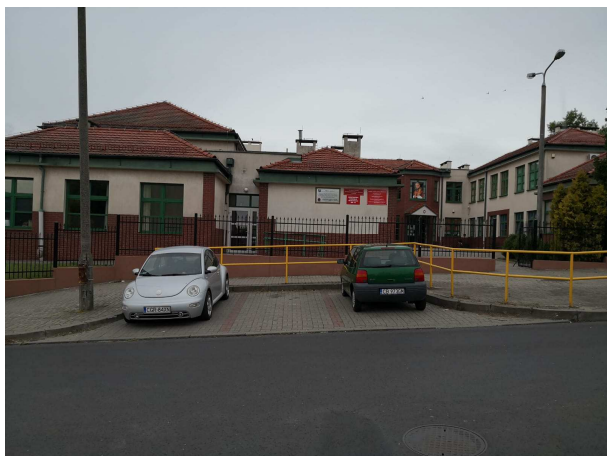
Zdjęcie nr 1: Istniejący parking przewidziany do przebudowy
