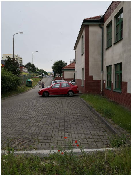
Zdjęcie nr 4: Istniejące zaplecze szkoły utwardzone kostką brukową betonową
